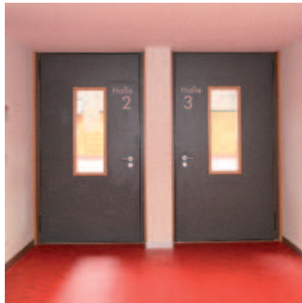
Hallengegenseitiger Türbelag aus Schichtstoff
