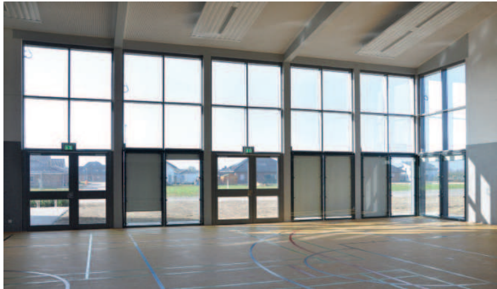
Die Flügel der Glasprallwand lassen sich auf Wunsch öffnen
