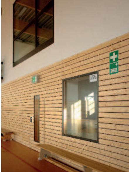
Regieraumfenster mit Kraftabbau
