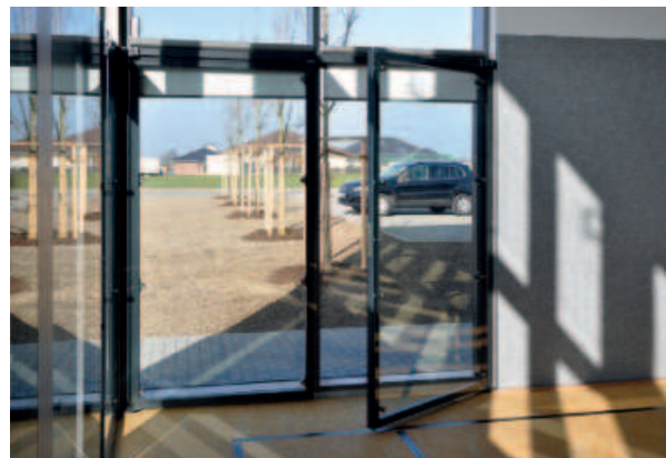
Die Flügel der Glasprallwand lassen sich auf Wunsch öffnen
