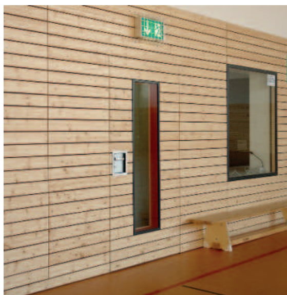
Sporthallentüren als Brandschutztür mit Rauchschutzfunktion T-30 RS
