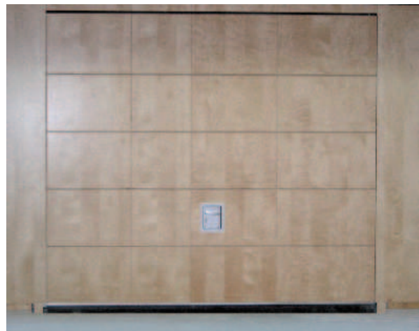
Sektionaltor und Prallwand aus gleichem Holz-Paneel gefertigt
