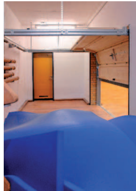
Das Sektionaltor öffnet senkrecht nach oben
