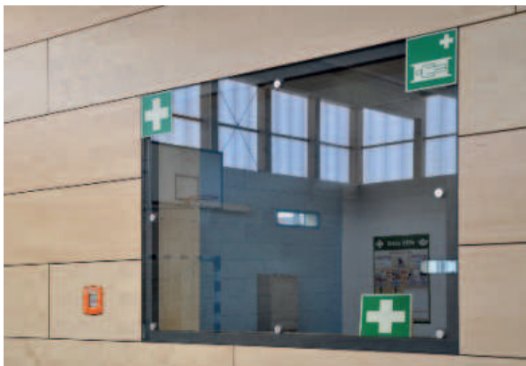
Kraftabbauendes Regieraumfenster mit Glaspunkthaltern
