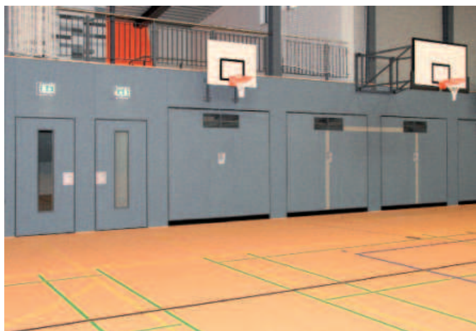
Geräteraumtore und Turnhallentüren mit textilem Prallbelag
