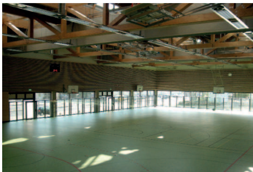
Glasprallwand mit Kraftabbau
