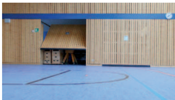
Geräteraumtore mit Fichte Glattkantprofilen
