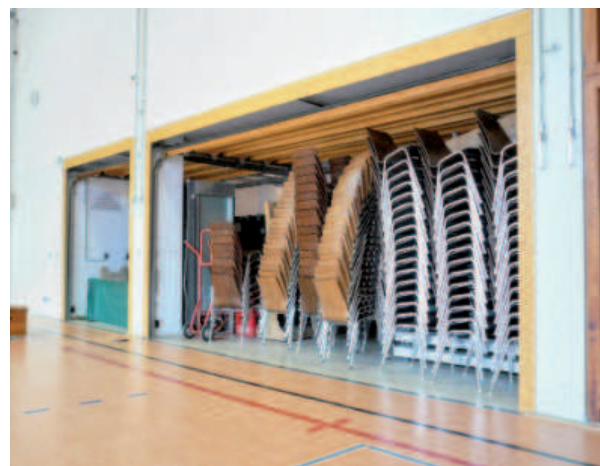
Das Sektionaltor öffnet senkrecht nach oben
