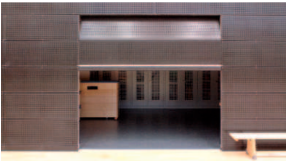
Sektionaltor und Prallwand aus gleichem Holz-Paneel gefertigt
