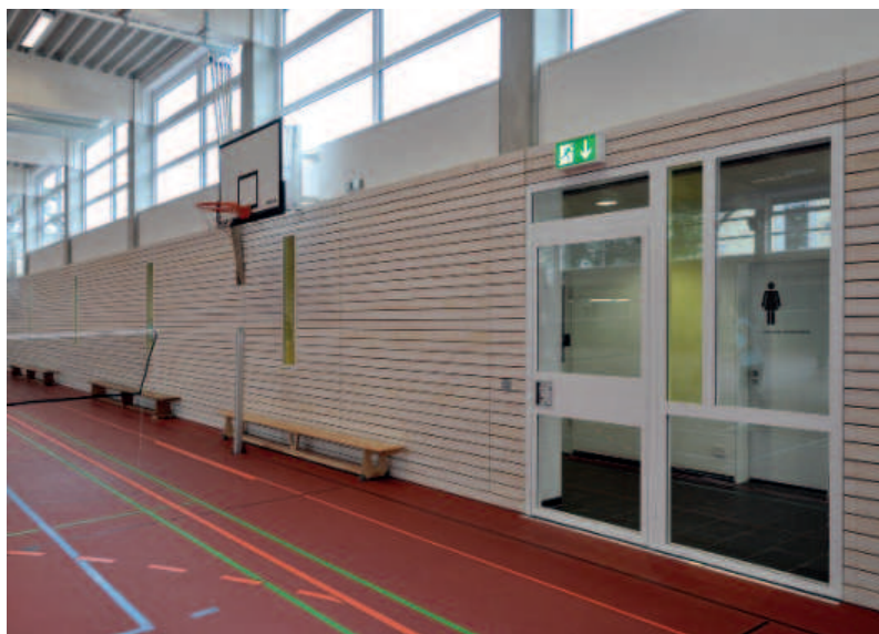
Ballwurfsichere Stahl-Glastüre für die Sporthalle
