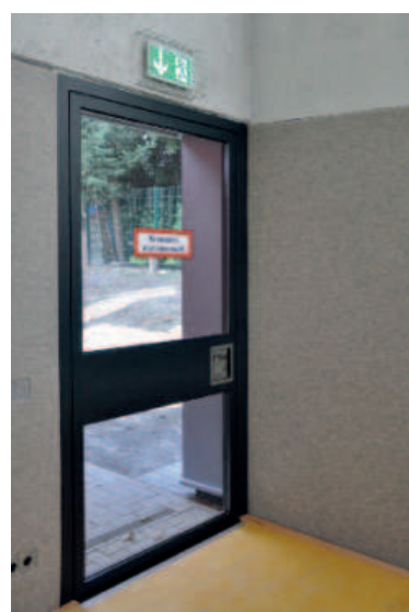
Stahl-Glastüre mit thermischer Trennung als Außentüre
