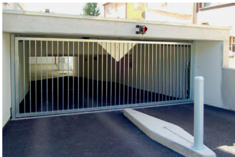
Kiptor mit senkrechten Stäben und Durchgreifschutz für den Torantrieb
