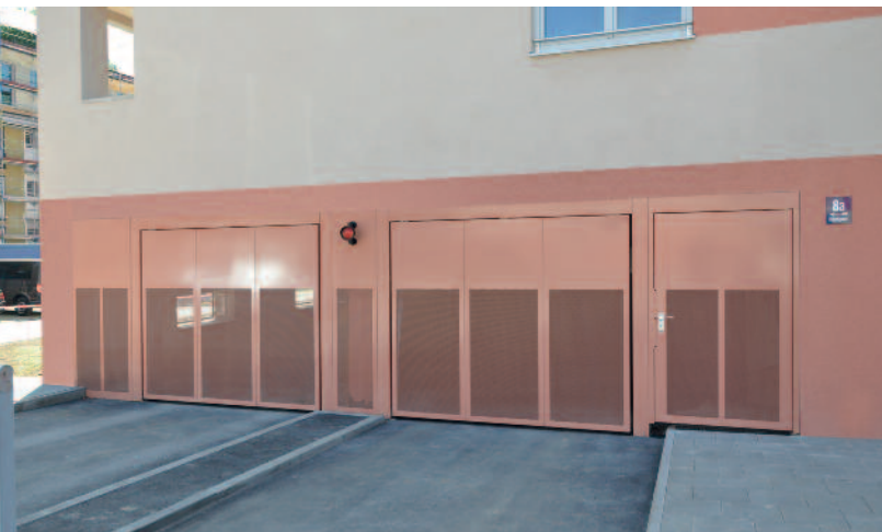
Die Torverkleidung aus Aluminiumblech wurde nach Kundenwunsch mit einem Laser bearbeitet
